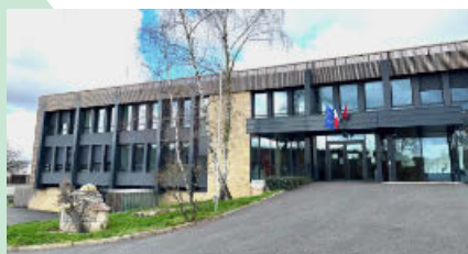
Création du nouveau siège du Grand-Figeac et structuration des services communautaires
