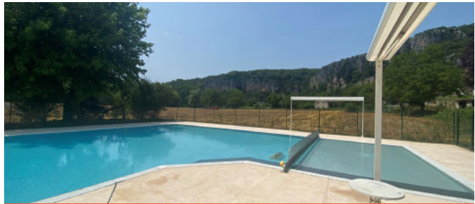
Piscine intercommunale de Saint-Sulpice
