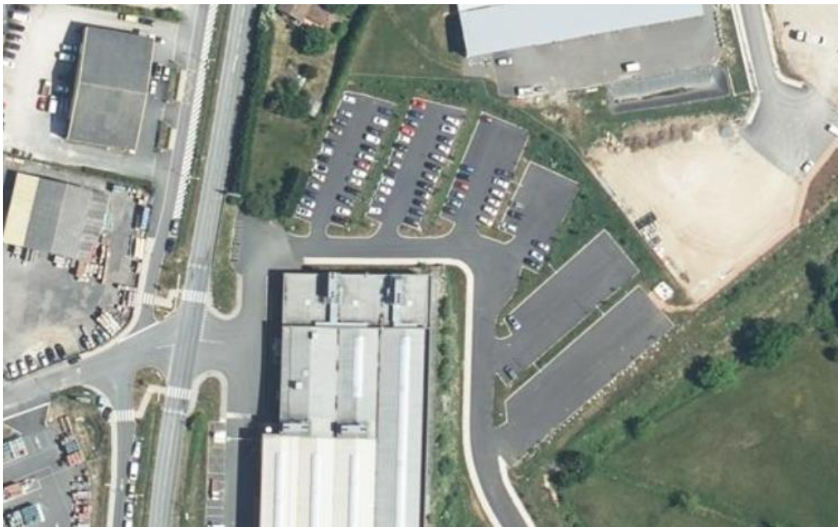
Figure 2 : Photo aérienne du site
