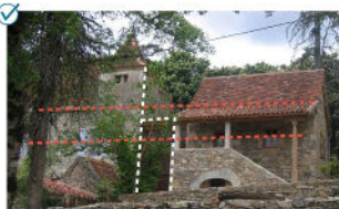
Extension respectueuse de l'existant et intégrant les codes de l'architecture traditionnelle / alignement des lignes fortes et des ouvertures en façade (lignes en orange et blanc) © philia Architectes
